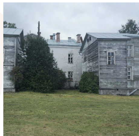
До начала работ
