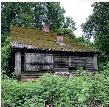
До начала работ
