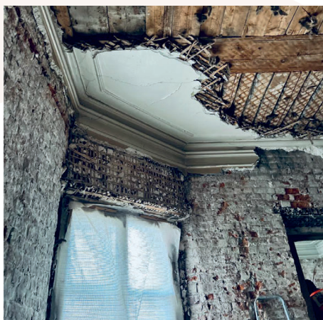
Фото до начала работ
