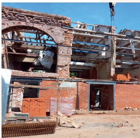
Во время проведения работ
