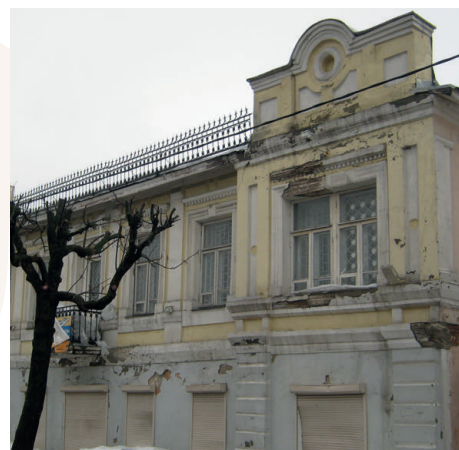
До начала работ
